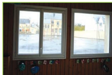
Remplacement de fenêtres du préau
