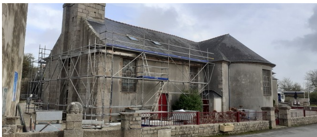
Les échafaudages extérieurs fin décembre
