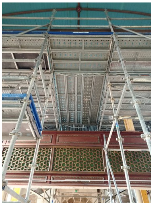
L'échafaudage au dessus de la tribune
